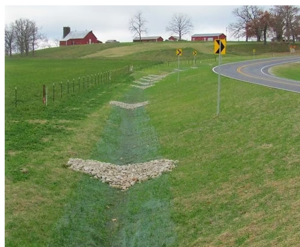
Misure di ritenzione naturale delle acque (es. piccole dighe, bacini di ritenzione, traverse)
