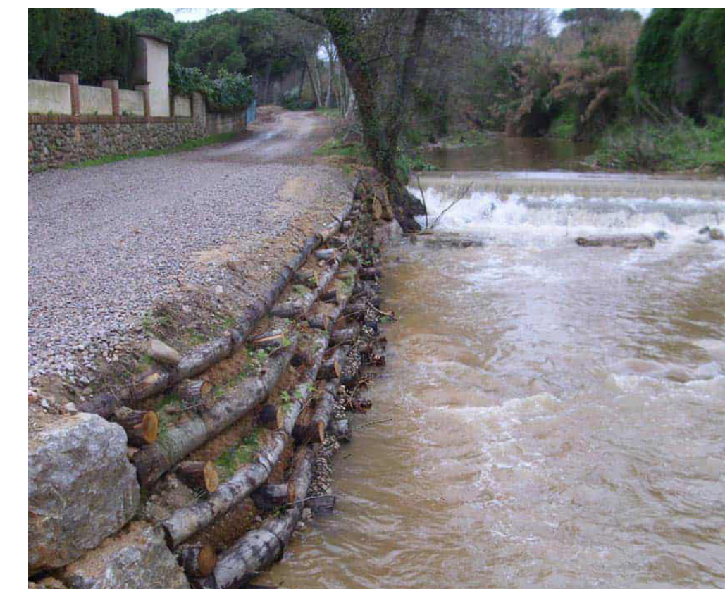
Αποκατάσταση / Ενίσχυση φυσικών όχθων ποταμών
